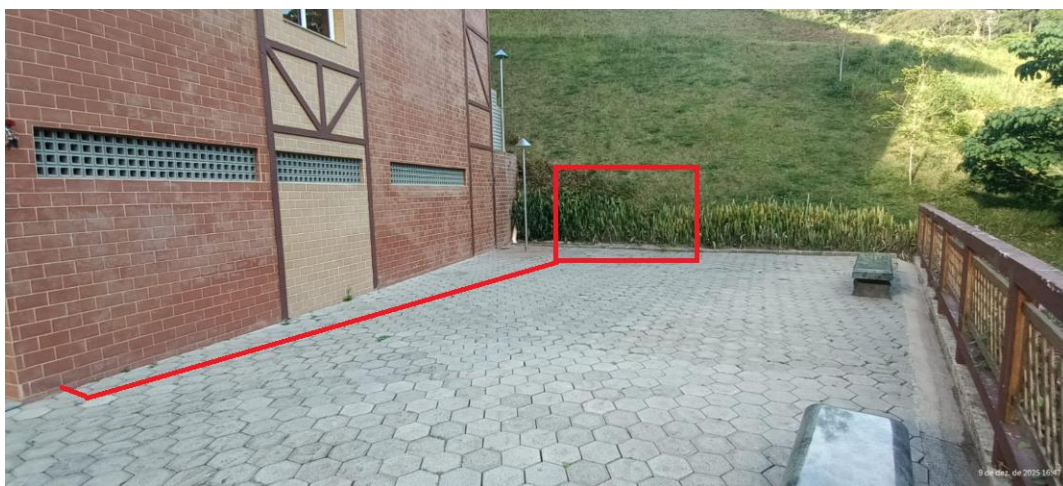
Bloco 4 - Gerador de 150kV, local a ser instalado.
