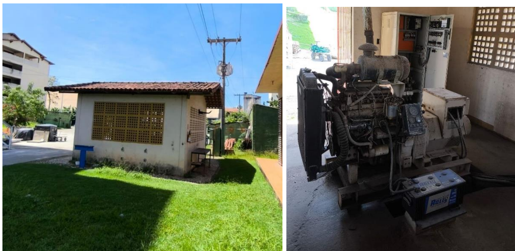
Local de instalação e equipamento existente
