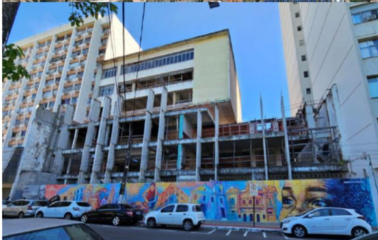
Foto 01: fachada da Rua Padre José de Anchieta nº 58
