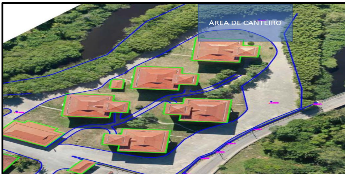
Figura 1 - Canteiro de obras
