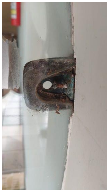
Fotos – Ferragens desgastadas por oxidação
