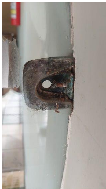
Fotos – Ferragens desgastadas por oxidação
