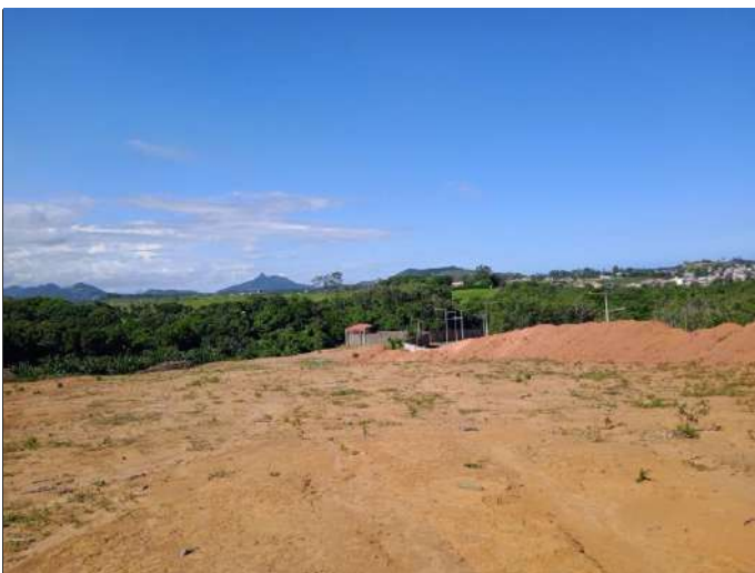
Foto 11 – Vista do platô superior
