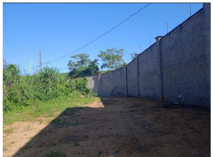
Foto 6 – Vista do muro após o portal de entrada
