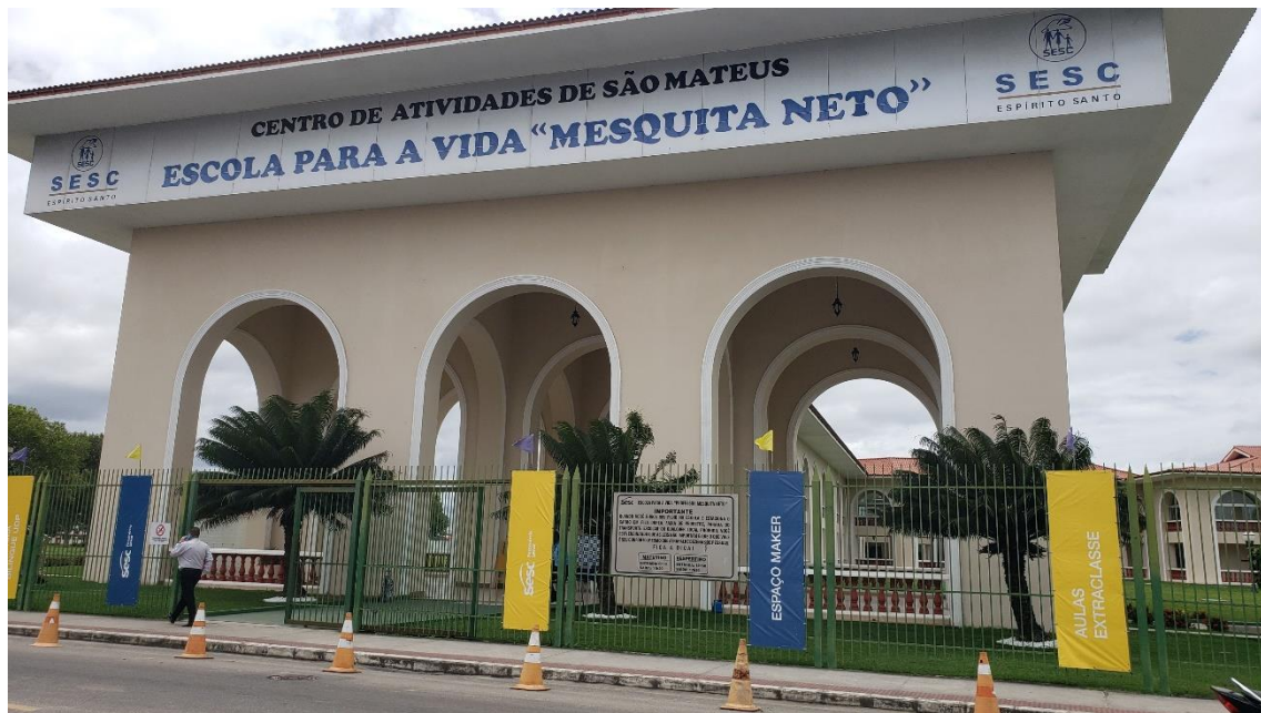
Foto 01: Portal de Entrada do Centro de Atividades.
