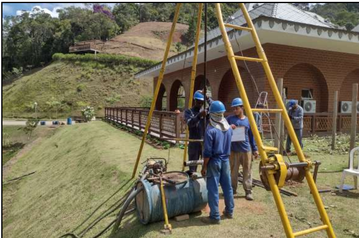
Figura 3: Vista geral da área e a realização da sondagem no furo SP-02.
