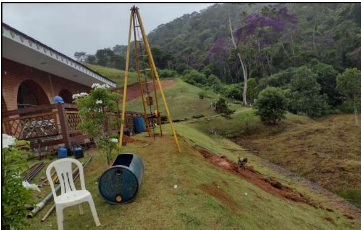
Figura 2: Vista geral da área e a realização da sondagem no furo SP-01A.
