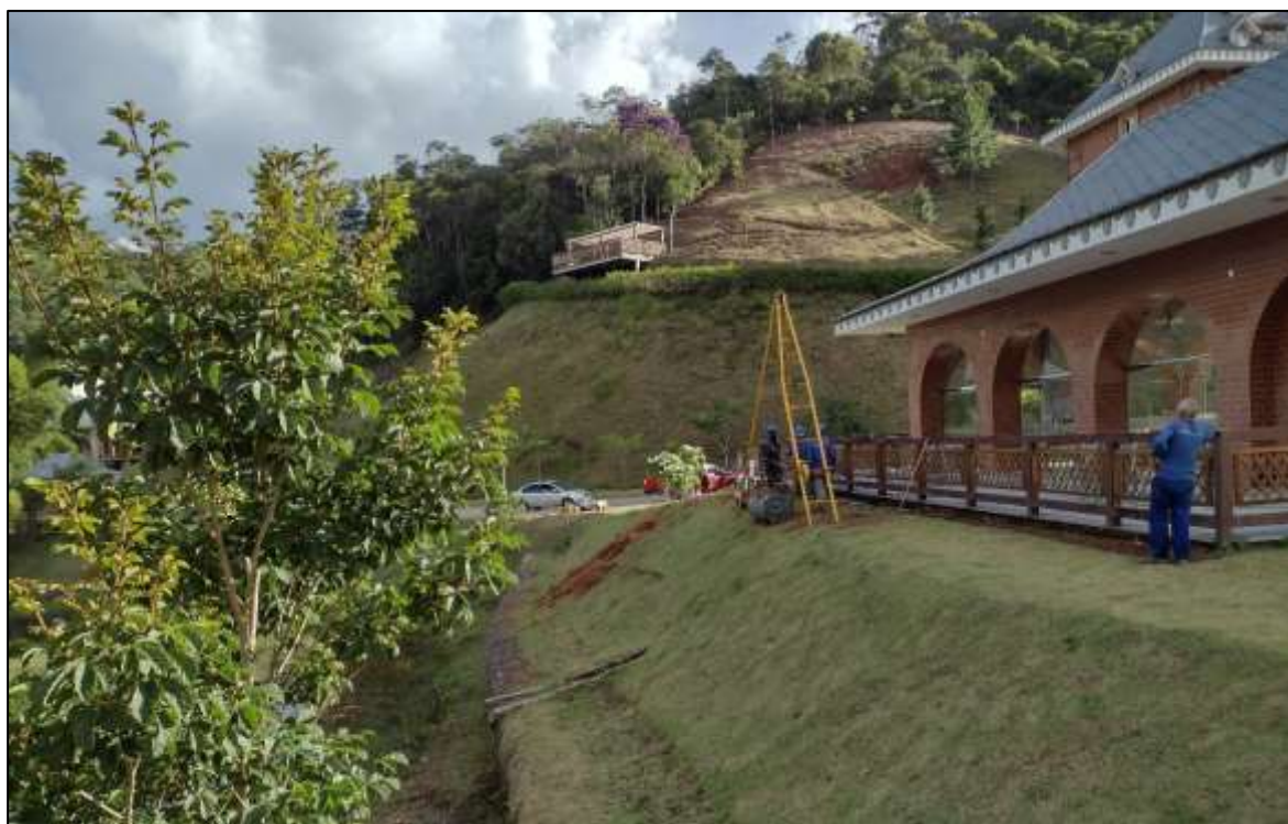
Figura 4: Vista geral da área e a realização da sondagem no furo SP-03.
