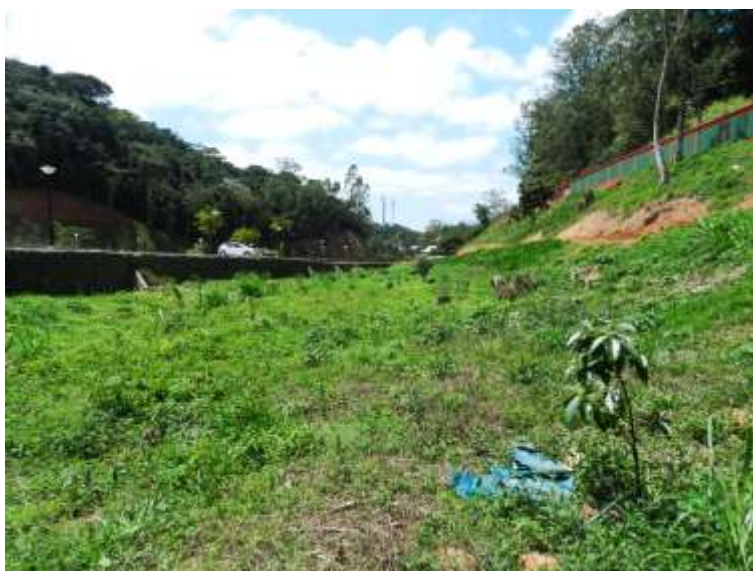
Figura 6: Perspectiva da área 2, com os muros de contenção ao lado esquerdo e talude ao lado direito.
