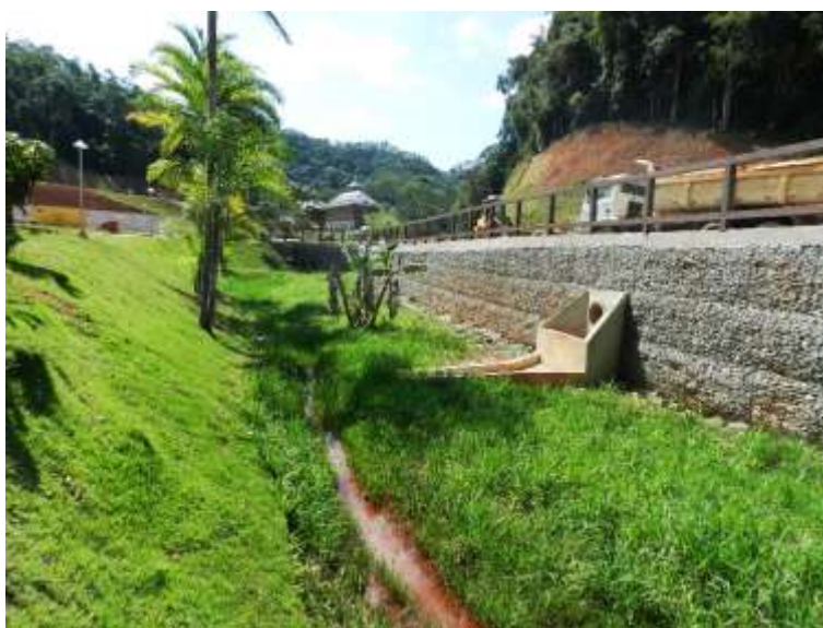
Figura 2: Perspectiva da área 1. Ao lado esquerdo observa-se o talude, ao centro a área de baixada, trespassada pelo curso d'água, e ao lado direito, o muro de contenção e as canaletas para escoamento de água da chuva.
