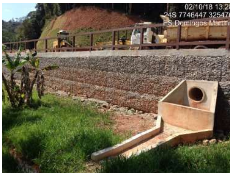
Figura 4: Muro de contenção e canaletas de para escoamento de água da chuva.
