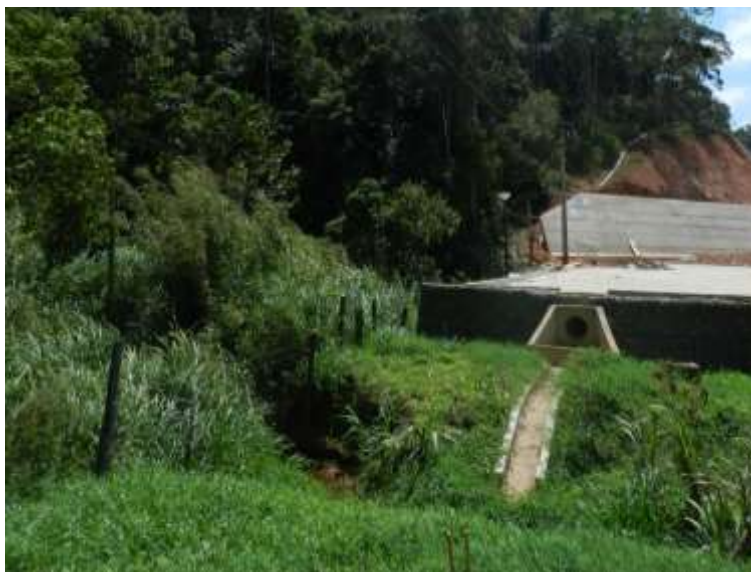
Figura 26: Área 2 a ser recuperada, já delimitada por cercamento.
