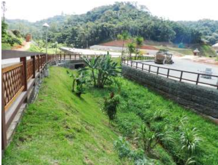
Figura 23: Área 1 a ser recuperada, já delimitada pelos muros de contenção.
