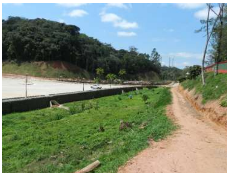
Figura 25: Área 2 a ser recuperada, já delimitada pelos muros de contenção e estrada.
