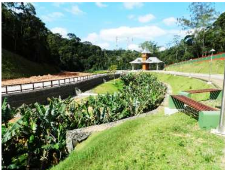
Figura 3: Muros de contenção as margens da área 1, e presença de indivíduos de bananeira ao longo do curso d'água.
