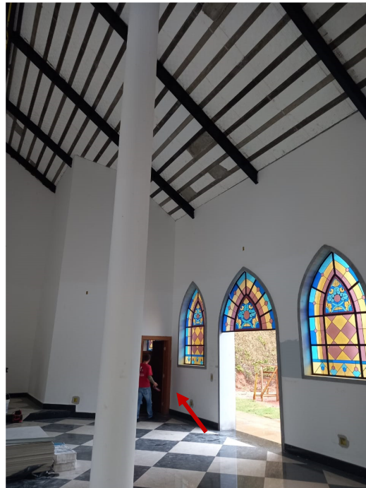
FOTO 06: CAPELA ECUMÊNICA/BANHEIROS - INTERNO
