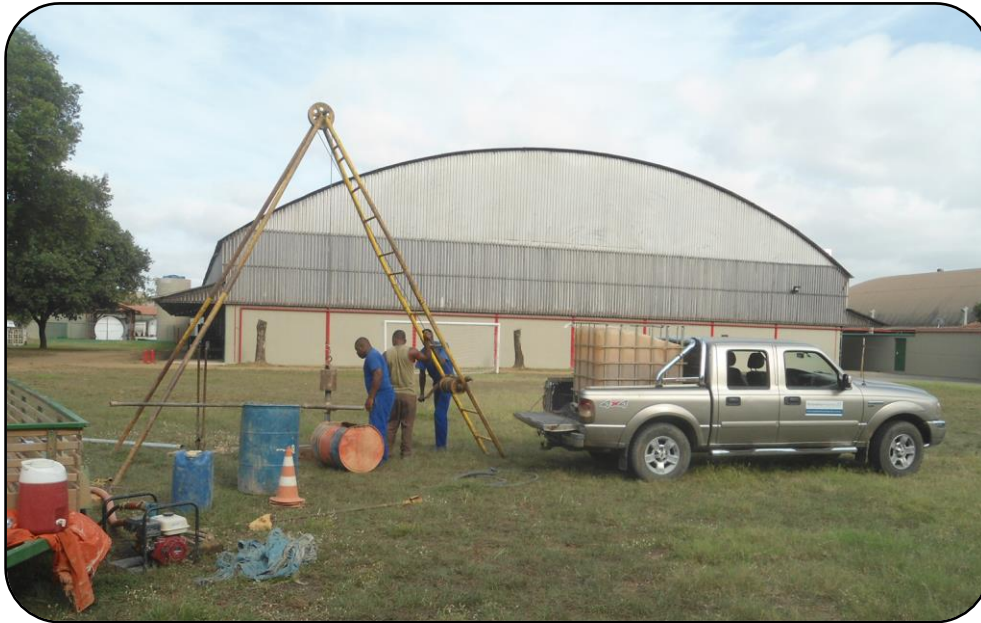
Figura 3: Trabalho de colocação do revestimento e localização do furo SP-05.
