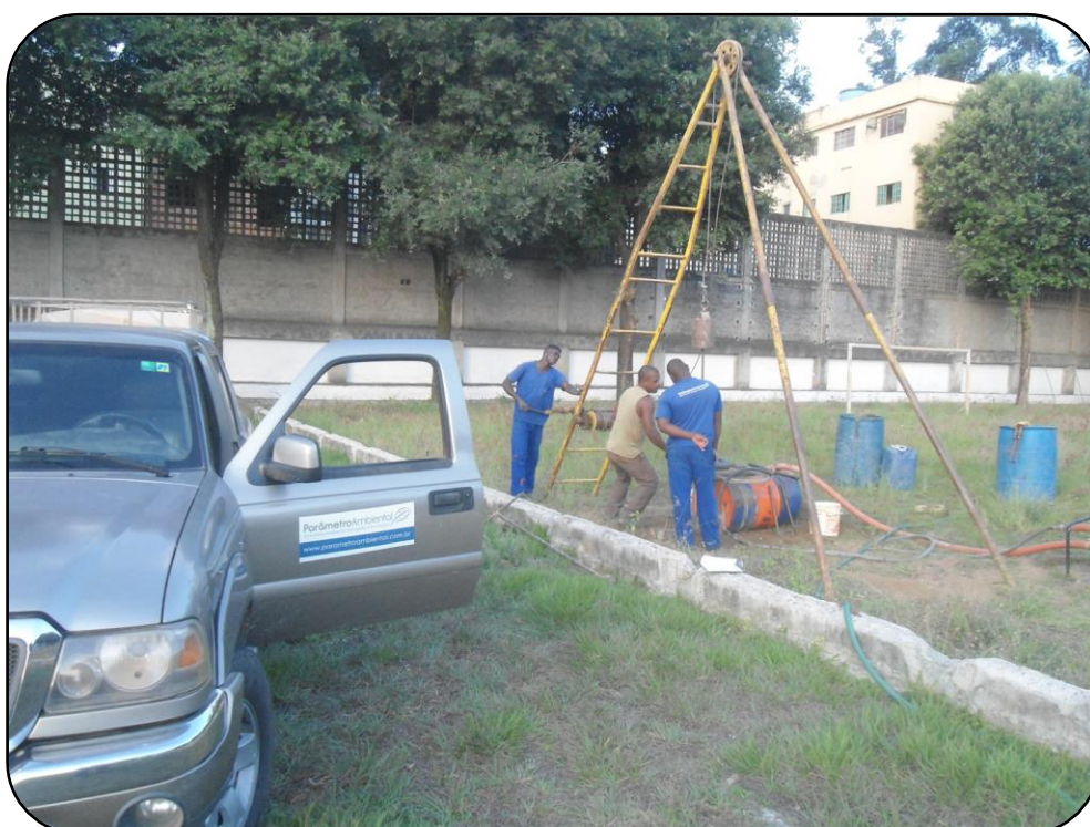
Figura 2: Execução da perfuração SP-04.
