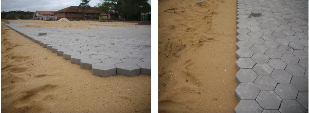
Figura 04 e 05 – Parte do novo estacionamento do Centro de Turismo de Praia Formosa, a qual já havia recebido calçamento.
